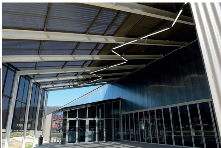
L'enveloppe est constituée d'une couverture et d'un bardage double peau et polycarbonate.
