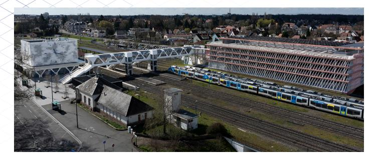
Il s'agit d'un parc de stationnement ventilé, avec une structure en béton armé et précontraint, afin de privilégier les très grandes portées (15,50 m), l'objectif étant que les plateaux de stationnement soient le plus transparent possible pour les utilisateurs.
